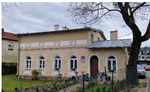
Fot. 4.83. Ul. Sobieskiego i Dworcowa, Wejherowo
