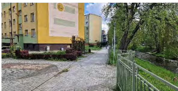
Fot. 4.19. Bulwary nad rzeką Łebą, Lębork
