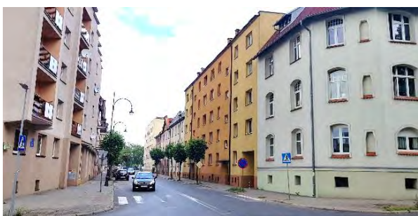
Fot. 4.11. Remonty budynków mieszkalnych w rejonie ul. Drzymały, Chojnice
