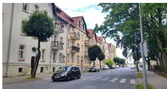
Fot. 4.12. Remonty budynków mieszkalnych w rejonie ul. Drzymały, Chojnice
