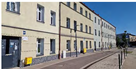
Fot. 4.40. Przebudowa ul. Szkolnej, Słupsk
