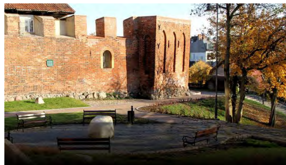
Fot. 4.59. Historyczne mury obronne, Tczew
