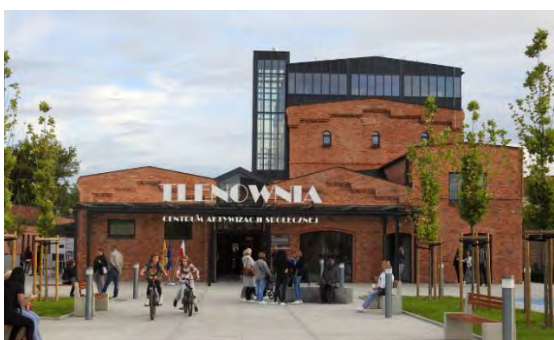
Fot. 1.4. Centrum Aktywizacji Społecznej ul. Nowa, Czempin
